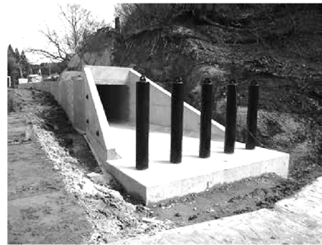
Fig.4 流木捕捉工による廃止事例 5) Abolition case by drift wood capturing structure
