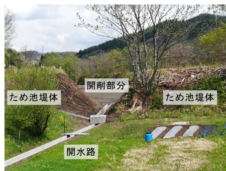
Fig.2 開削工法による廃止事例 Abolition case by open cut method
